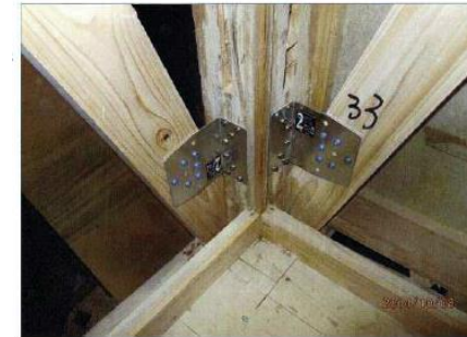
筋かい金物による補強
