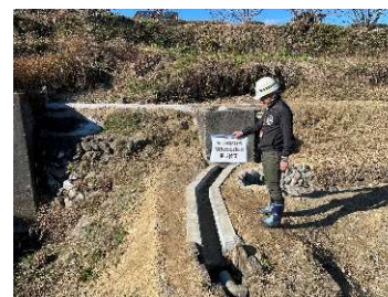
R6 柿の木田水路修繕工事（吉野）
