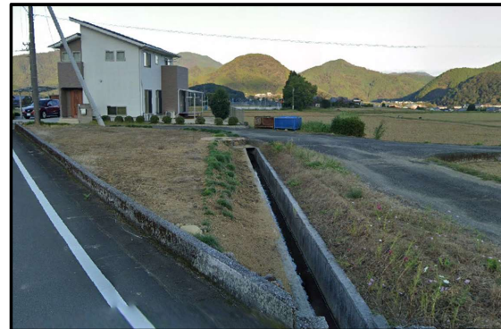
豊岡前水路補修 水路工 L=17m
