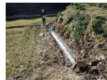
R7 エンザコ水路改修工事（上家地）
