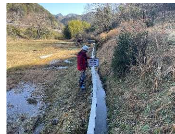
R4 女郎水路改修工事（蔵生）
