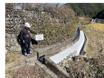
R5 大井手水路改修工事（奥野川）
