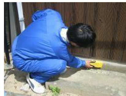
基礎の鉄筋確認
