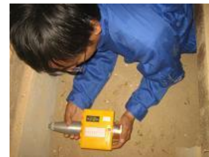
基礎のコンクリート強度調査
