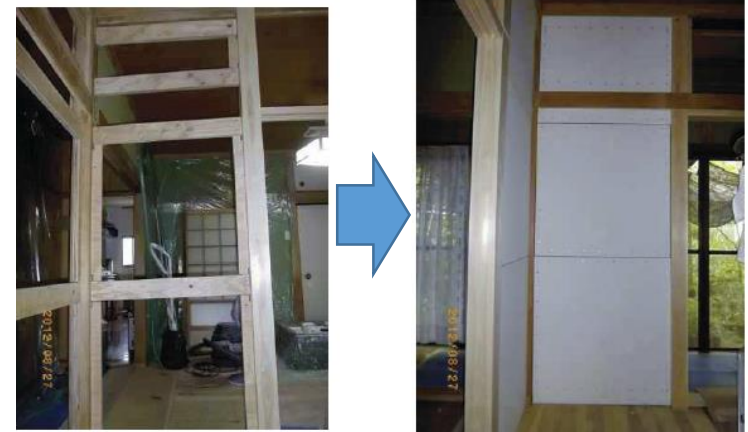
耐震パネルによる補強
