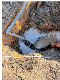
現在も漏水が発生しています。 ※現在の漏水修繕の様子
