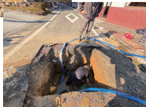
現在も漏水が発生しています。 ※現在の漏水修繕の様子
