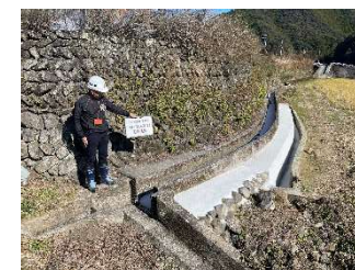
R5 大井手水路改修工事 (奥野川)
