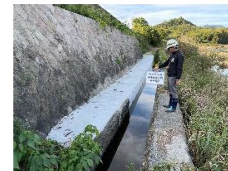
R6 祝井井手農業用水路改修工事 (松丸)
