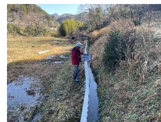
R4 女郎水路改修工事 (蔵生)
