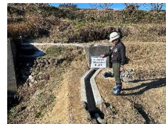
R5 両井出水路改修工事 (豊岡前)
