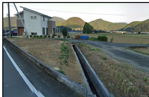
豊岡前水路補修 水路工 L=17m
