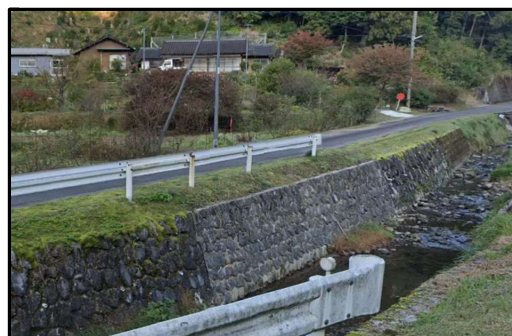
町道馬船線石積補修 石積工 L=11m A=28m 2 防護柵復旧工 L=9m
