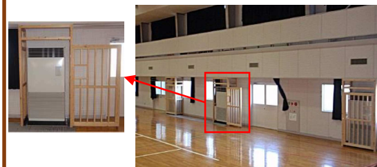
空調設備・防護枠イメージ
