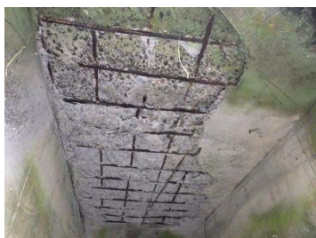
主桁のコンクリートが剥離し、鉄筋が露出しています 塗装の劣化が進み、鋼桁や支承が腐食しています
