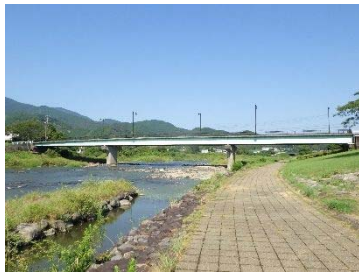
大門橋 (鋼橋 橋長 103m)
