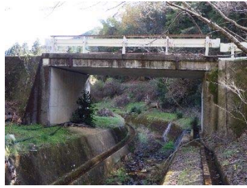
黒ヶ谷橋 (コンクリート橋 橋長 8m)
