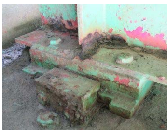
主桁のコンクリートが剥離し、鉄筋が露出しています 塗装の劣化が進み、鋼桁や支承が腐食しています
