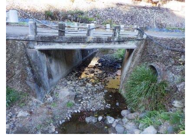
宮乃橋 (コンクリート橋 橋長 4m)
