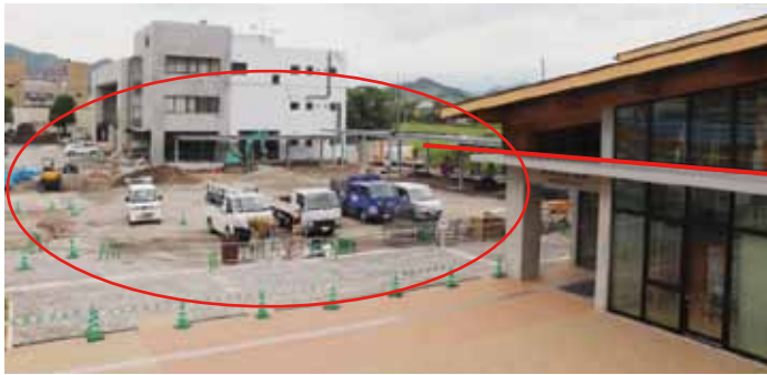
来庁者駐車場整備工事状況
