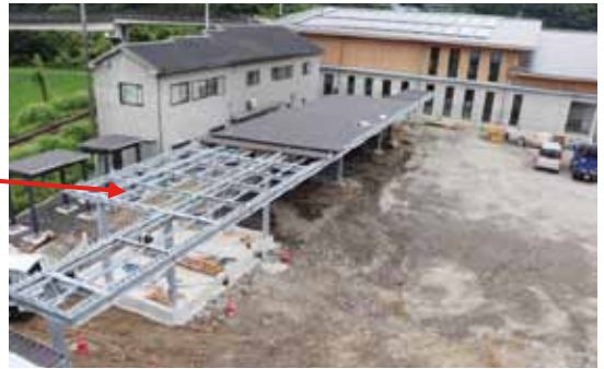
付属棟（渡り廊下・駐輪場等）建設状況
