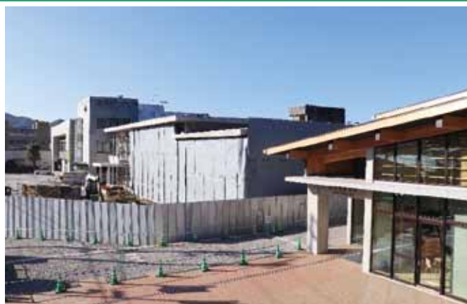
旧庁舎解体工事 防音シート設置作業
