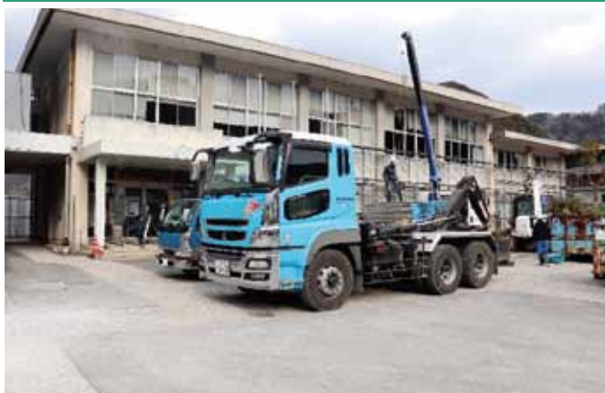
旧庁舎解体工事 足場設置作業
