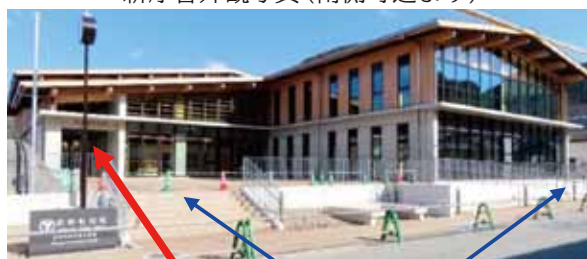
新庁舎外観写真(南側町道より)
