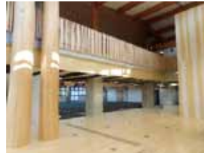
1階待合ロビー・執務室
