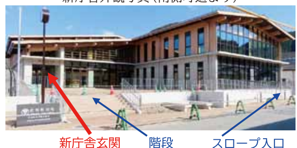
新庁舎外観写真(南側町道より)
