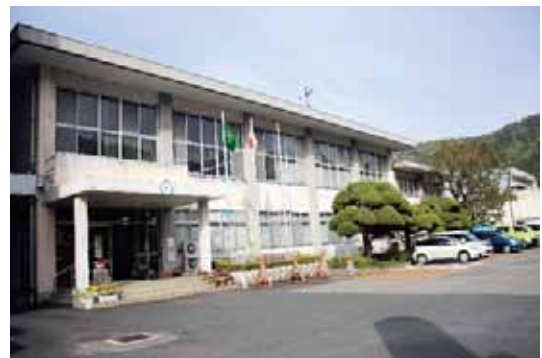
旧庁舎外観(昭和36年建築・60年経過)
