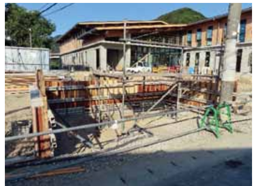
バス停移設基礎工事【庁舎前町道沿い】
