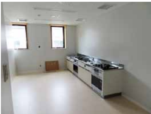
調理室【防災拠点施設1階】
