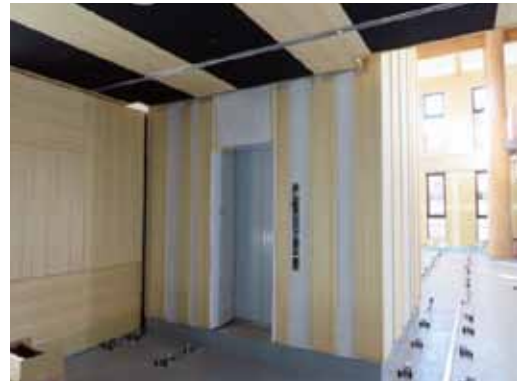
エレベーター設置【庁舎1階ロビー】
