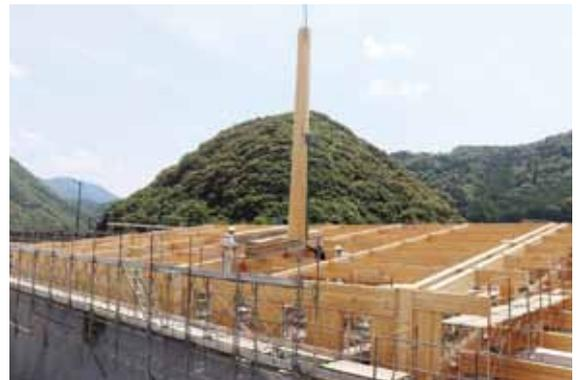
磨き丸太設置作業 (屋根側からクレーンにて搬入)
