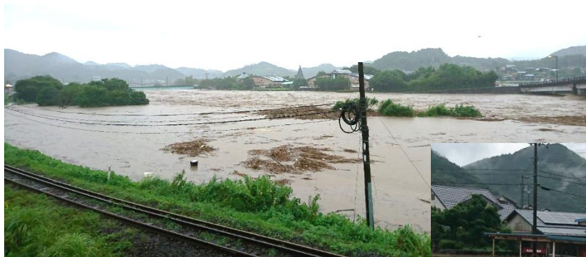
▲広見川洪水状況（虹の森公園付近）
