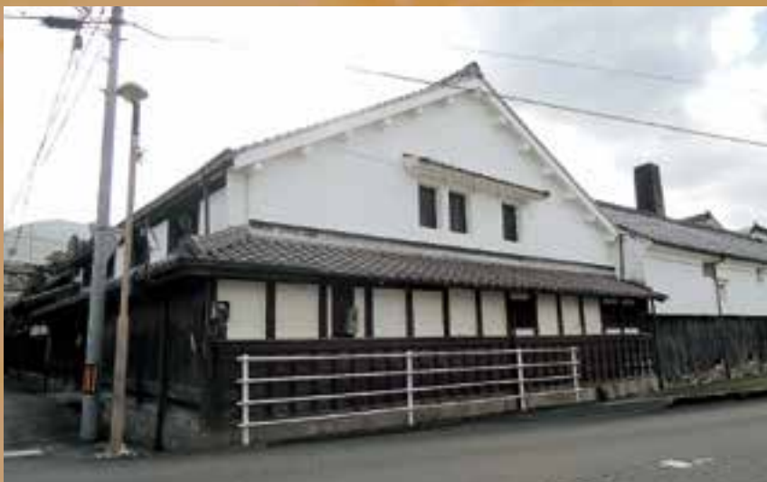
▶ 正木本店店舗兼主屋の外観
