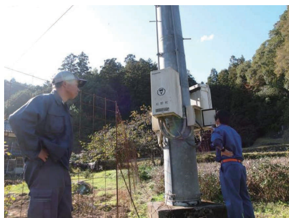
図 9-1-19 防災無線の機器確認
