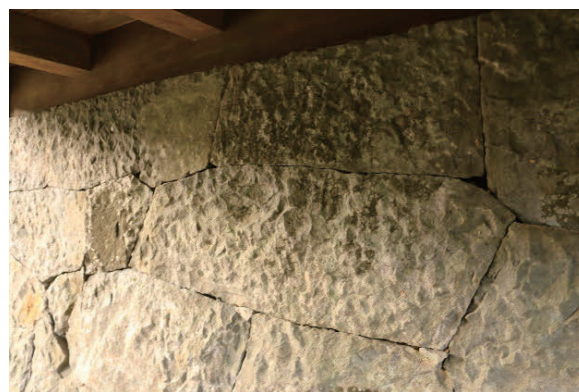
図 4-1-24 石材表面のノミ痕
