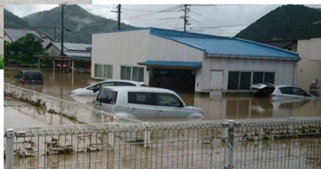
▼保健センター駐車場の浸水状況
