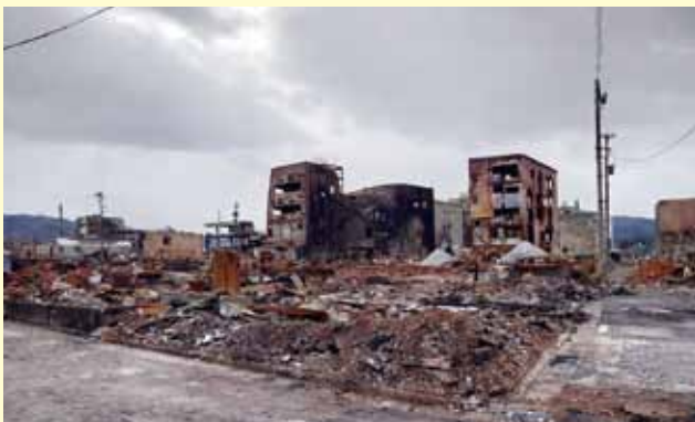
焼失した輪島朝市の町並み
