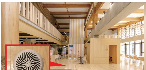
床吹き出し空調・待合ロビー
