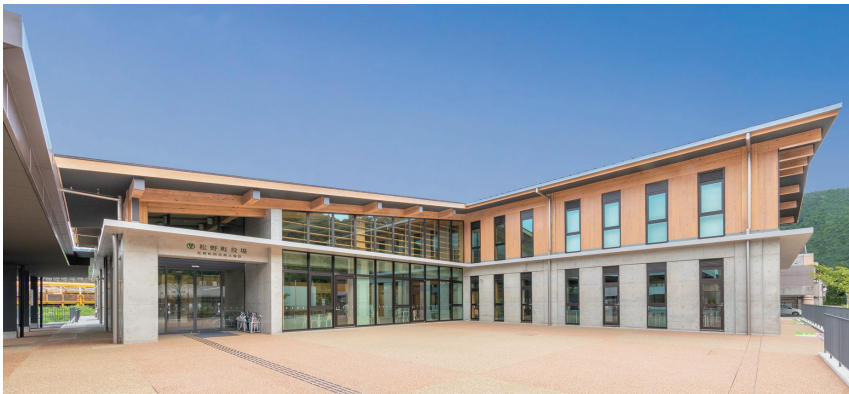
南側外観 2階木造部分外壁:CLT耐震パネル(町産スギ)
