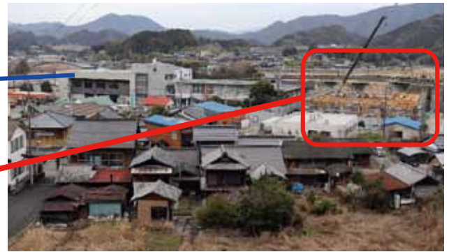
1階躯体工事状況 (天満神社より撮影)
