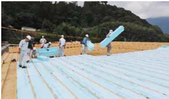
屋根工事①：断熱材敷設状況
