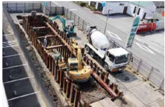
浄化槽工事①：基礎工事状況
