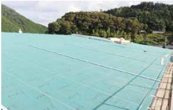
屋根工事②：防水シート敷設状況
