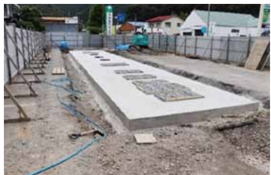
浄化槽工事③：設置完了
