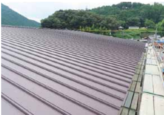
屋根工事③：屋根完成（金属屋根瓦棒葺き）
