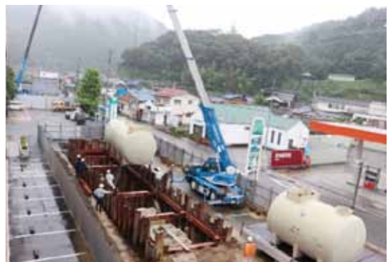
浄化槽工事②：本体設置状況
