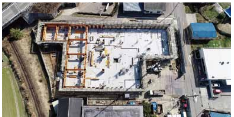
④土間・床コンクリート打設工事
