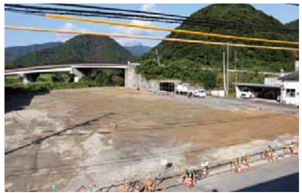
町民センター解体工事完了
