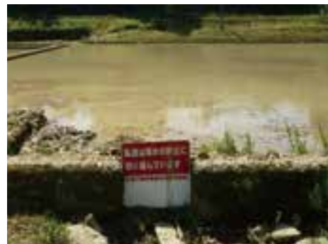
濁水の流出を抑制する「止水板」
