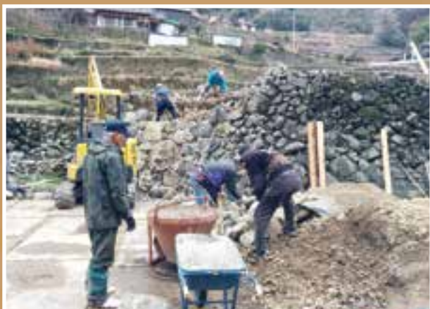
▲修復作業の様子
