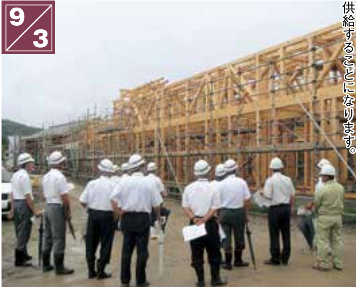
工事現場の移り変わりは、松野中学校ホームページでもご覧いただけます。(http://matsuno-j.esnet.ed.jp/)
